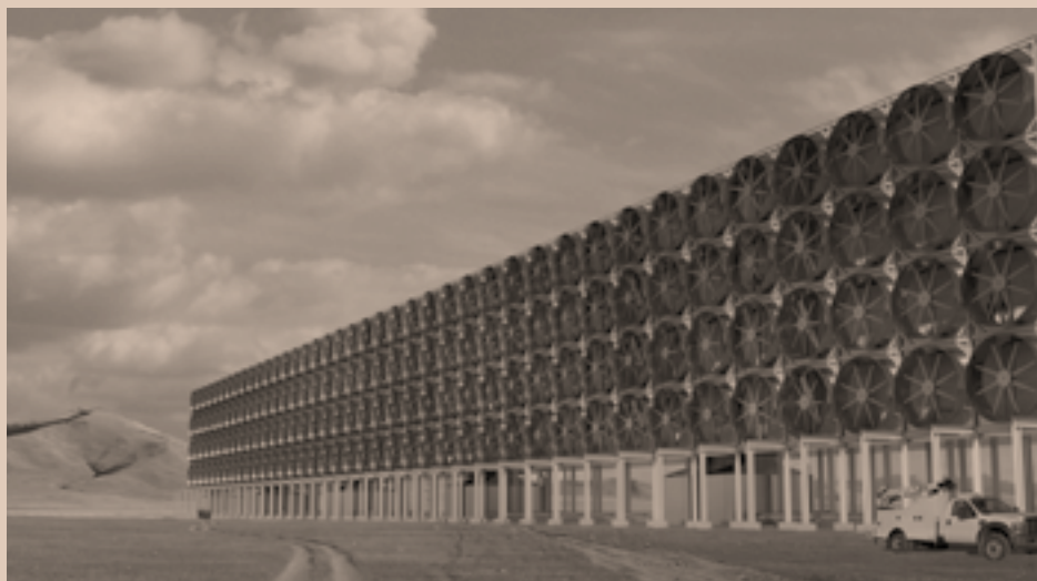
Imagem da nova unidade da Carbon Engineering (capaz de capturar mais de 1 milhão de toneladas de CO 2 da atmosfera por ano)
